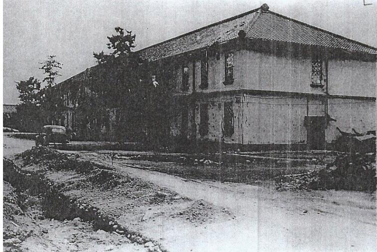
図 4 将校用捕虜棟 (1号棟)
